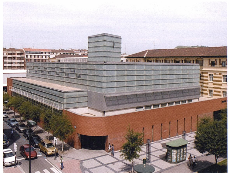
Vista exterior del edificio desde el acceso suroeste
