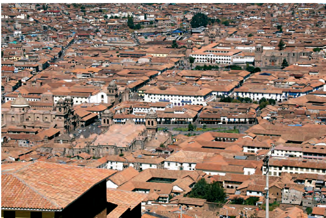
Vista del conjunto del área central del Cusco, en primer plano se ven las bóvedas de la Catedral y a la izquierda la Compañía de Jesús, delante de la cual se extiende el eje procesional.
