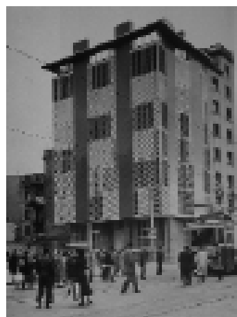
7. J.A.Coderch-M.Valls, Edificio de viviendas en la Barceloneta, Barcelona 1951-1955
