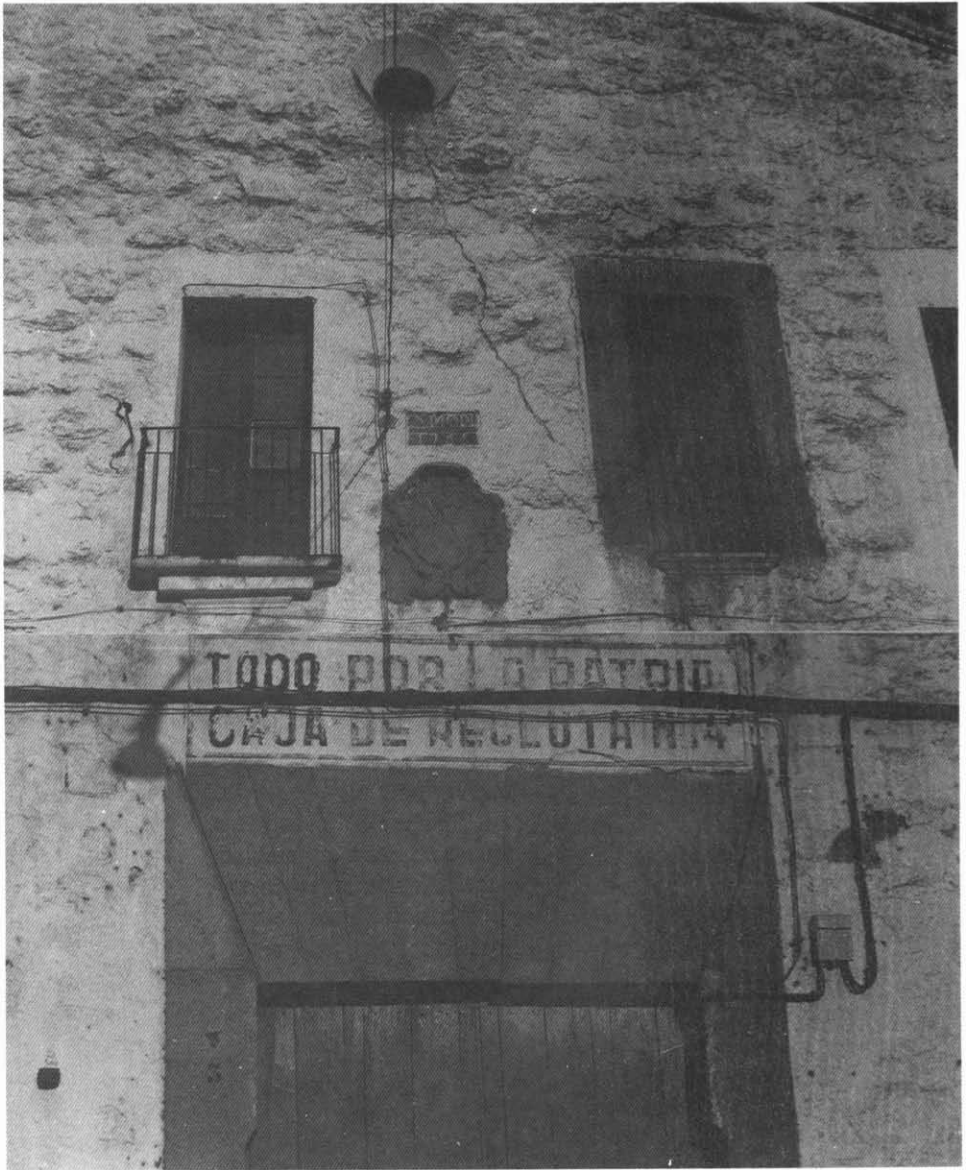
1. Alhóndiga de Plasencia. Detalle de la fachada.
