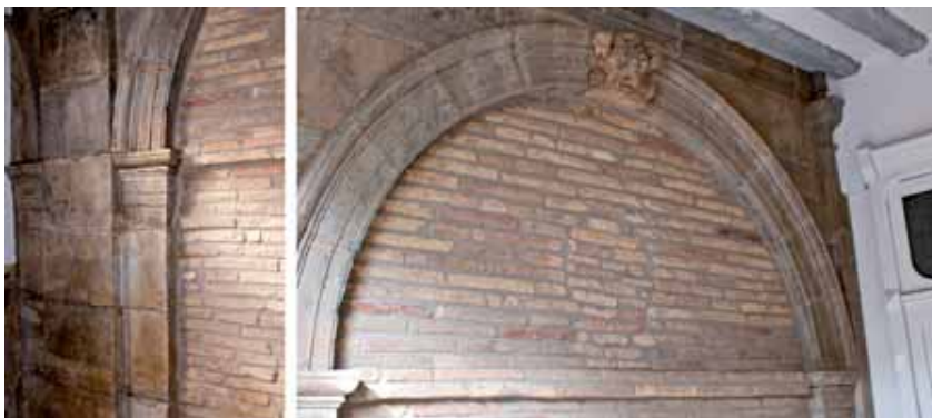
Arco ciego aparecido en interior de portal, con huellas de óvalo y ventana rectangular.
