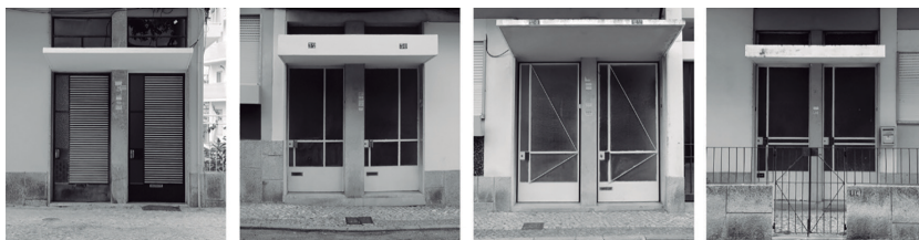
f2_Serie de cuatro accesos con puertas emparejadas de MGdC
