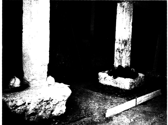
9. Rebaje de suelo de planta baja
