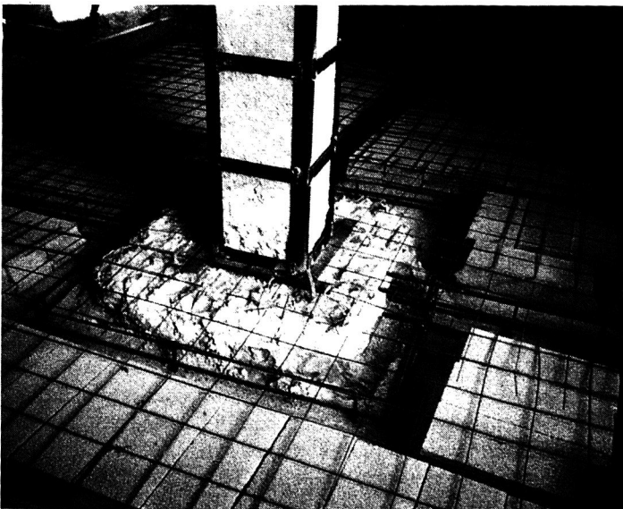
10. Detalle del arranque del pilar y zapata reforzados y suelo planta semisótano
