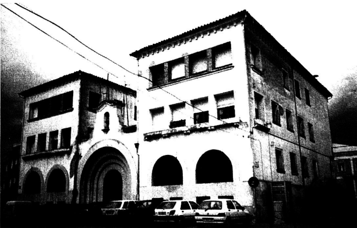
1. Imagen del conjunto previa a la intervención
