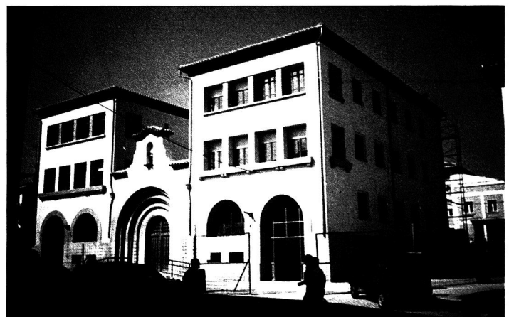
2. Imagen del conjunto tras la intervención
