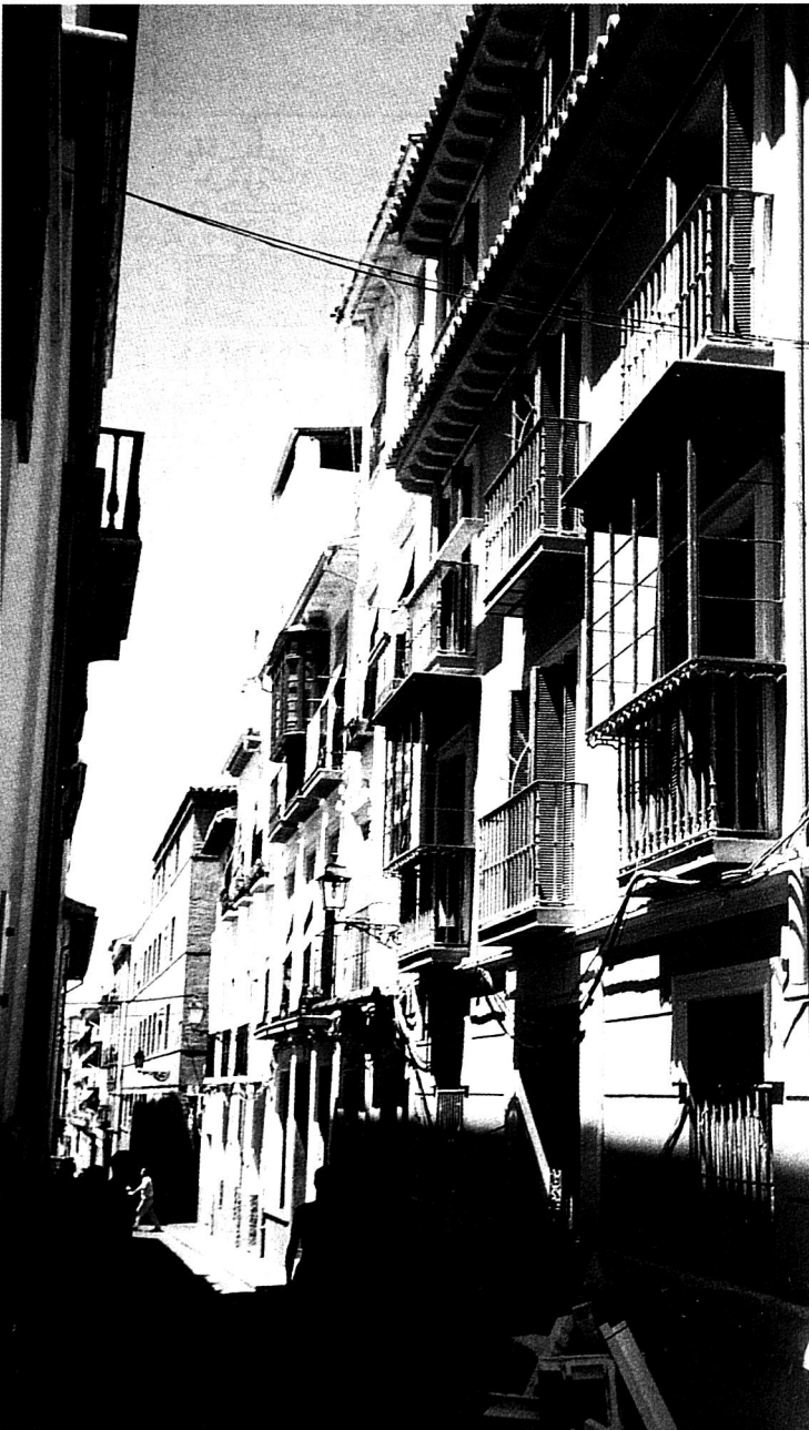
17. Estado final del inmueble rehabilitado
