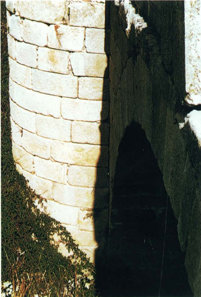
Fig. 5. Puente sobre el río Búrdalo. Estribo yuxtapuesto.
