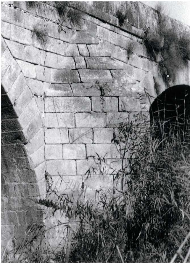
Fig. 3. Puente sobre el río Búrdalo. Tajamar aguas abajo.
