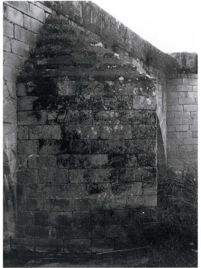
Fig. 4. Puente sobre el río Búrdalo. Tajamar contracorriente.
