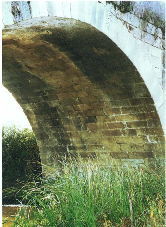
Fig. 7. Puente sobre el río Búrdalo. Bóveda del arco central.
