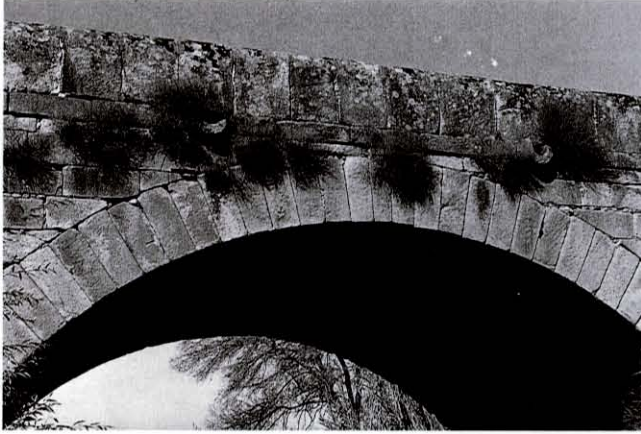
Fig. 8. Puente sobre el río Búrdalo. Detalle de la arquería.
