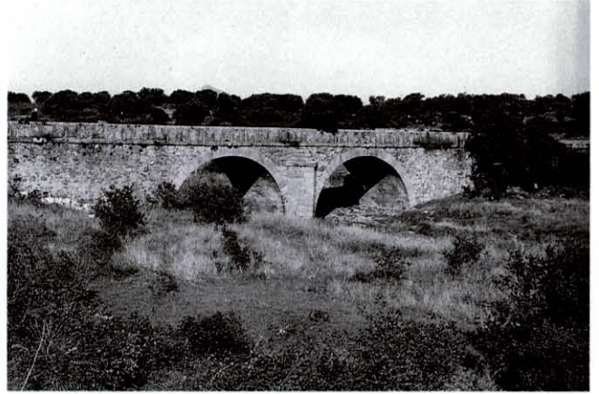
Fig. 10. Puente próximo a Villamesias.
