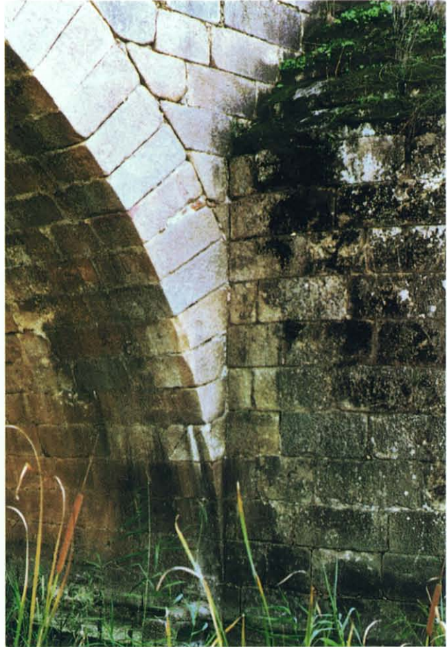
Fig. 6. Puente sobre el río Búrdalo. Detalle de la yuxtaposición del tajamar.
