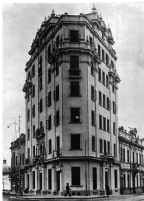
f4_Perspectiva de la fachada del edificio Rizo Patrón Archivo El Arquitecto Peruano, Sin título, Lima, 1940
