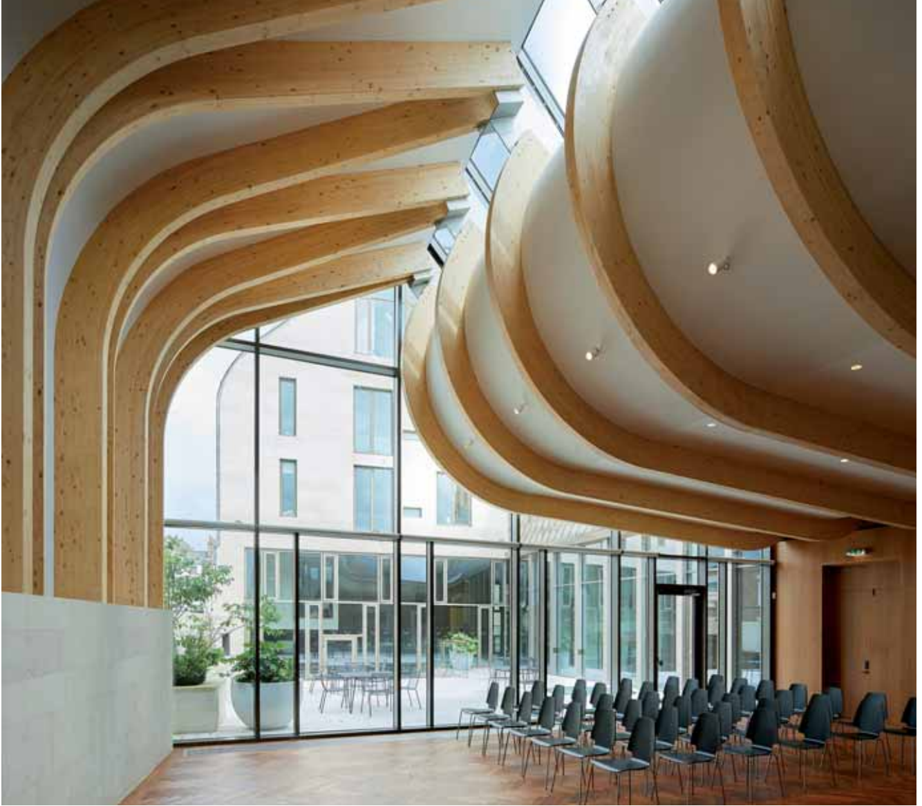
Imagen interior de la cubierta del Exter College, construida con elementos de madera laminada. (Fotografía del Estudio de Alison Brooks y de Hufton+Crow)
