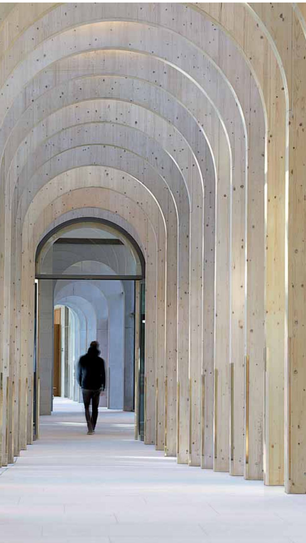
El claustro del Exeter College, construido con paneles contralaminados, es uno de los espacios de encuentro de la comunidad educativa
