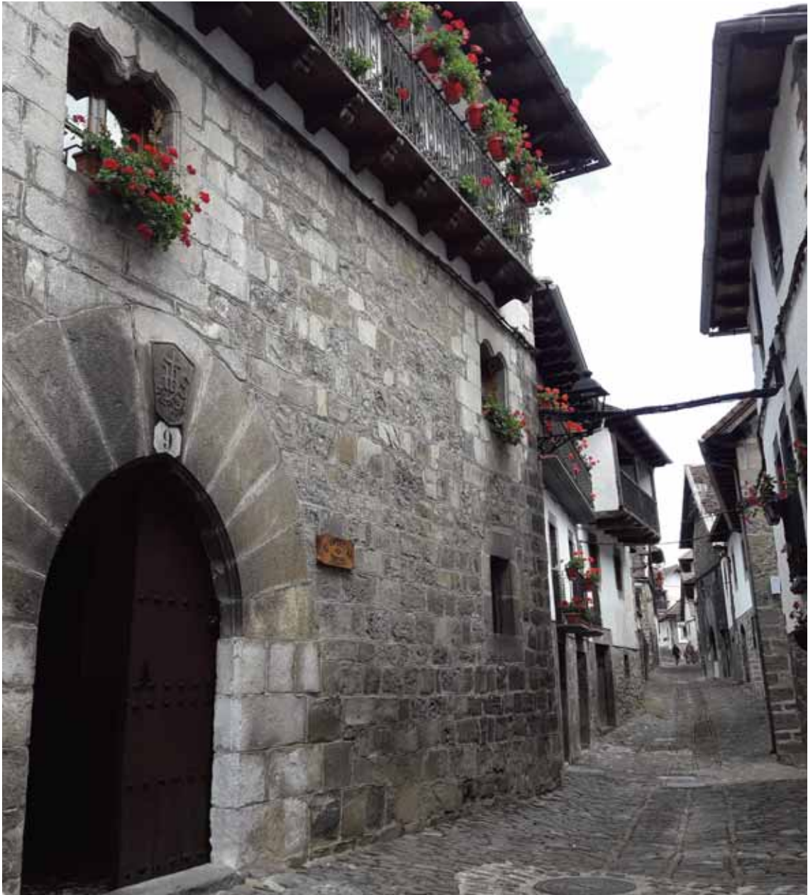
Lám. 33. Las fachadas en Ochagavía, como en otros pueblos pirenaicos, son compactas con ventanas pequeñas
