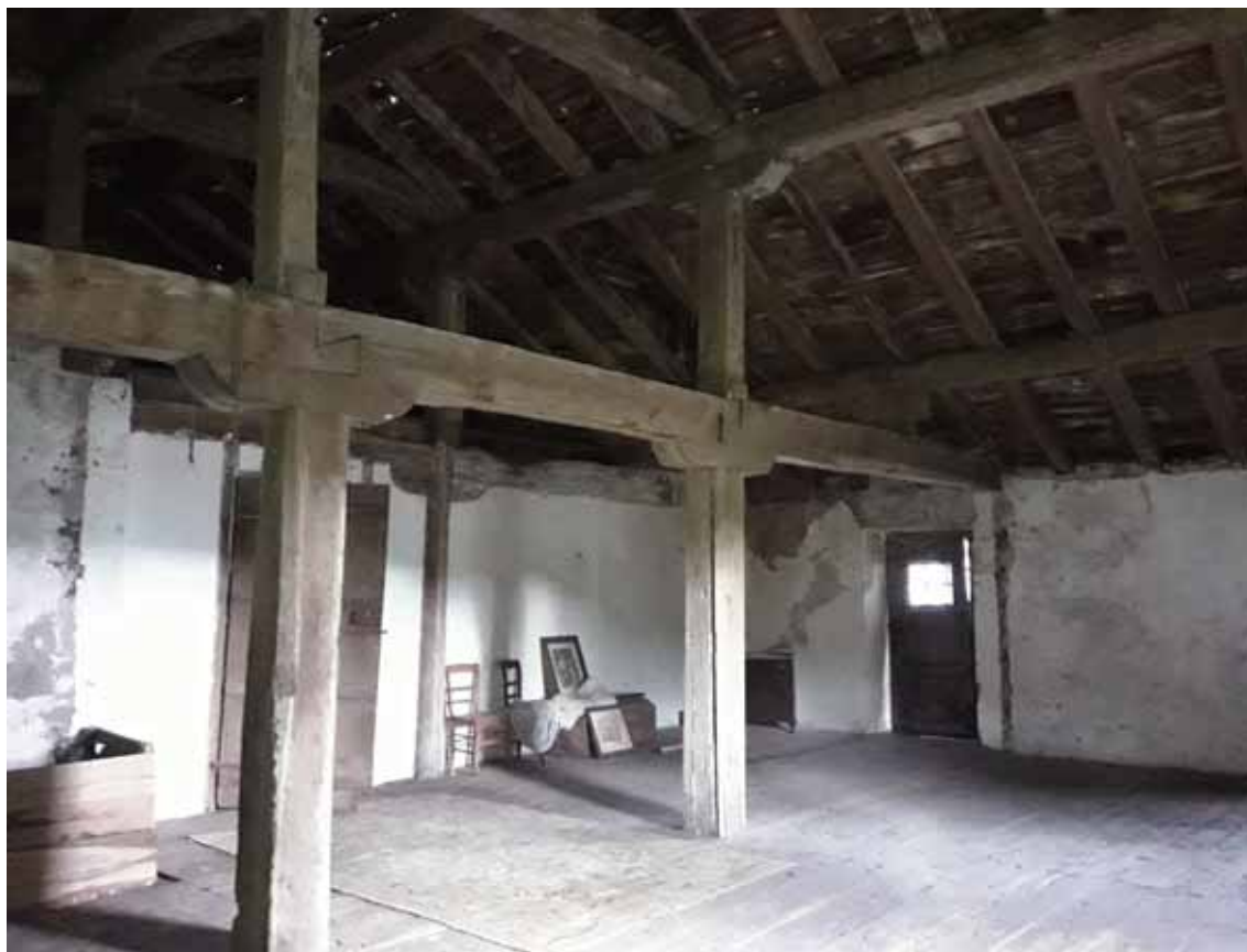
Lám. 48. Entramado del tejado de la Casa Buztinaga, Errazu
