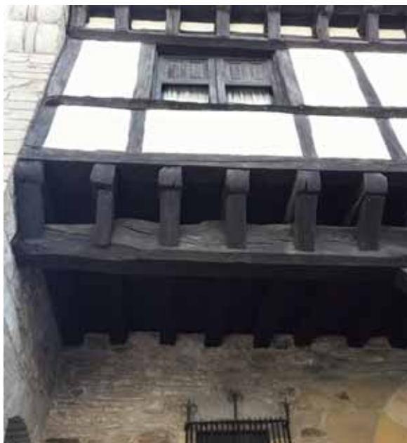
Lám. 41. Entramado de madera en la casa Yandenea, Goizueta
