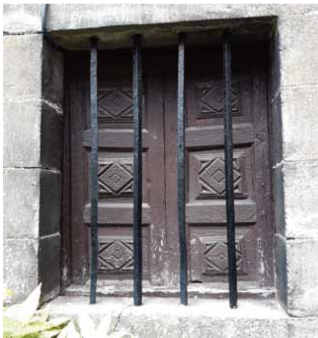
Lám. 49. Ventana. Esparza de Salazar
