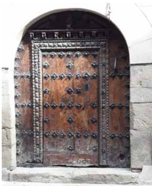
Lám. 52. Puerta. Casa en Lumbier
