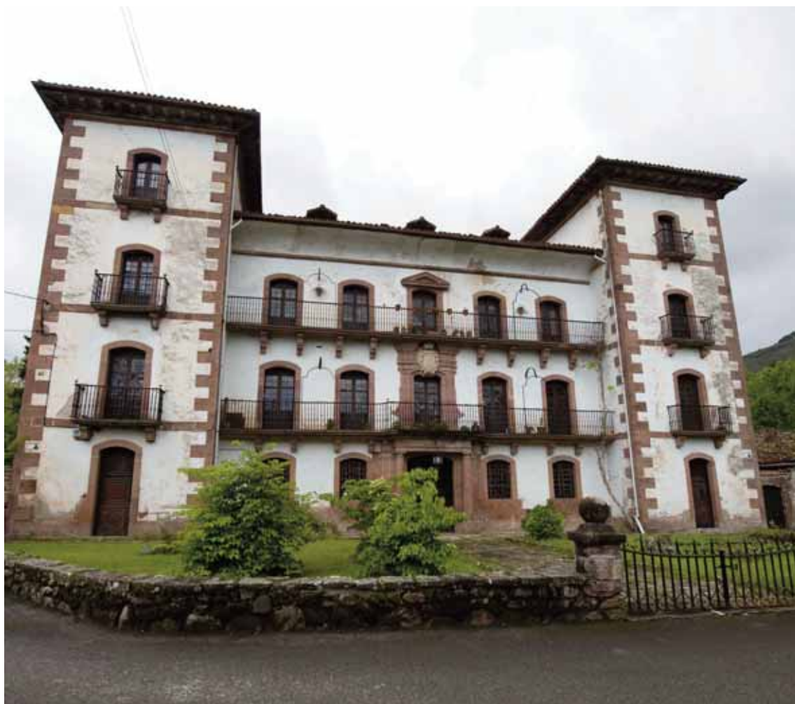
Lám. 23. Palacio Reparacea, Oyeregui
