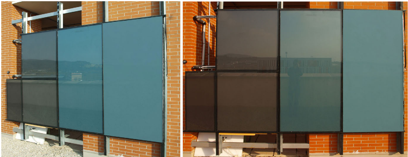
Figura 8. Prototipos construidos y activados, en fase de recogida de datos energéticos (ITC, 2013).
